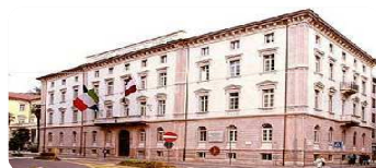
Trente – Sièges de l'Administration Provinciale Ex Poste – C. Dir. Europa Fungo
